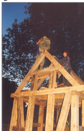
A, B, C, D. Składanie konstrukcji ryglowej (od położenia podwaliny do zawieszenia wiechy upłynęło siedem godzin). Fot. R. Berek, 2003
