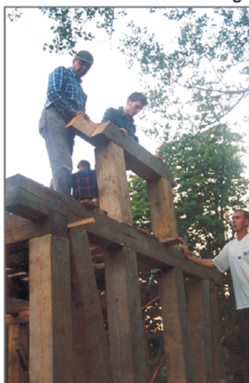
A, B, C, D. Składanie konstrukcji ryglowej (od położenia podwaliny do zawieszenia wiechy upłynęło siedem godzin). Fot. R. Berek, 2003
